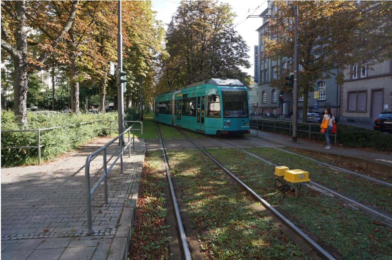
**Abb. 11:** Nach der Haltestelle Nauheimer Straße biegt die Linie 17 von der zweispurigen Strecke für einen kurzen Abschnitt auf die einspurige Strecke ein. Dadurch konnten die Alleebäume der Hamburger Allee in diesem Abschnitt erhalten bleiben.
