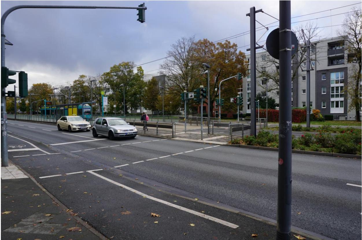
**Abb. 9:** Ein schlechtes Beispiel für die leichte Querbarkeit der Straßenbahntrasse ist die obere Friedberger Landstraße, hier an der Haltestelle Bodenweg. Grün für Fußgänger\*innen muss an jeder Fahrbahnseite der Hauptverkehrsstraße extra angefordert werden, es dauert sehr lange Zeit bis die Fußgängerampel nach der Bedarfsanmeldung auf Grün schaltet. Bis dahin ist die ankommende Straßenbahn eventuell bereits wieder weggefahren. (Foto: Willi Loose)
