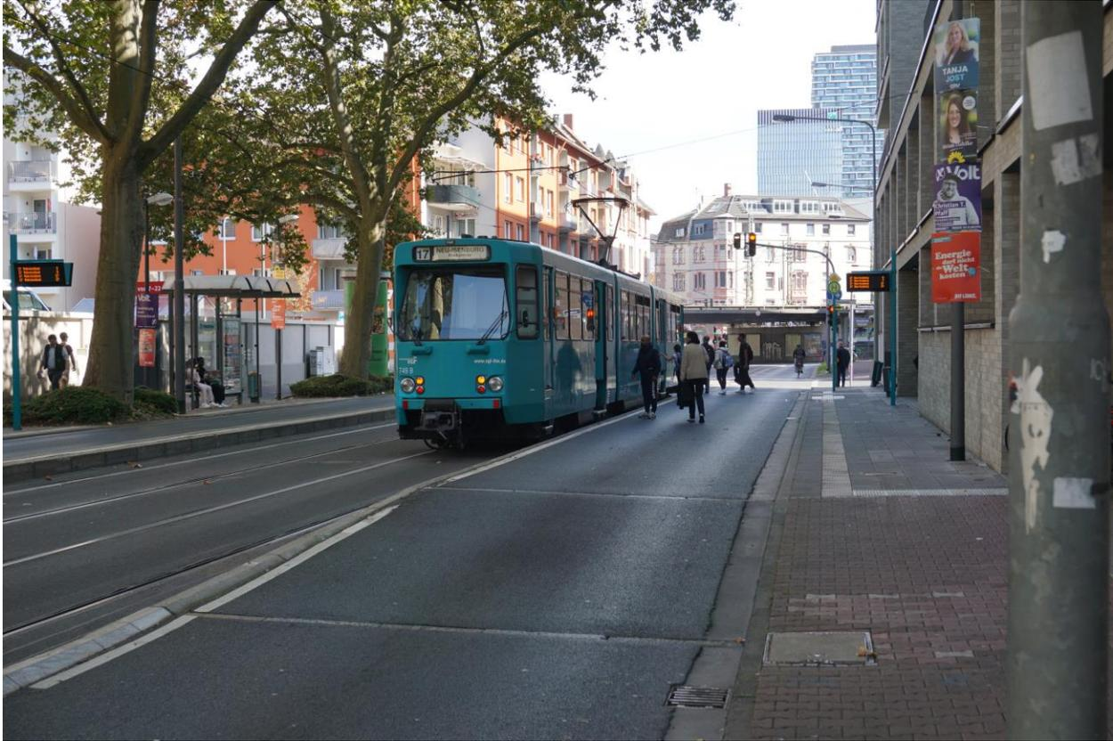
**Abb. 7:** Aufgepflasterter, fast ebenerdiger Haltestellenbereich in der Voltastraße an der Haltestelle Nauheimer Straße (Foto: Willi Loose)
